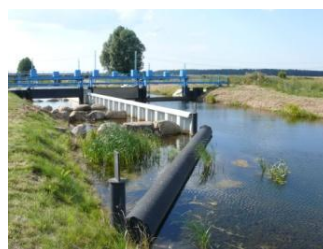
Querbauwerk mit neu gebauter Fischtreppe (BRAUNER 2008)
