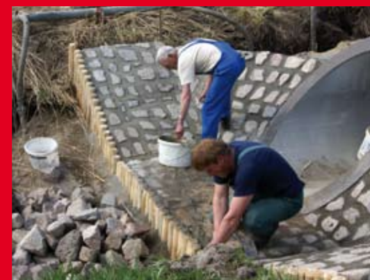
... Kelle und Mörtel
