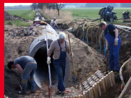
... beim Radwegebau kommt alles zum Einsatz
