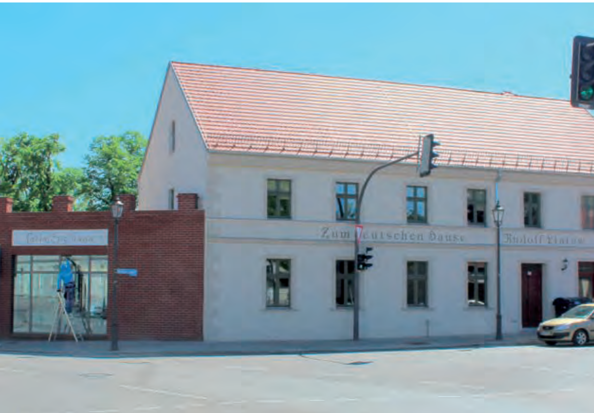
Abb. oben: Das Deutsche Haus nach Abschluss der Sanierungs- arbeiten 2019
