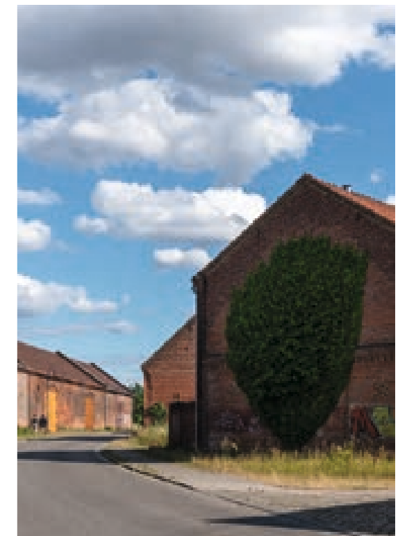
Scheunen in Altlandsberg. Foto: Erik-Jan Ouwerkerk.
