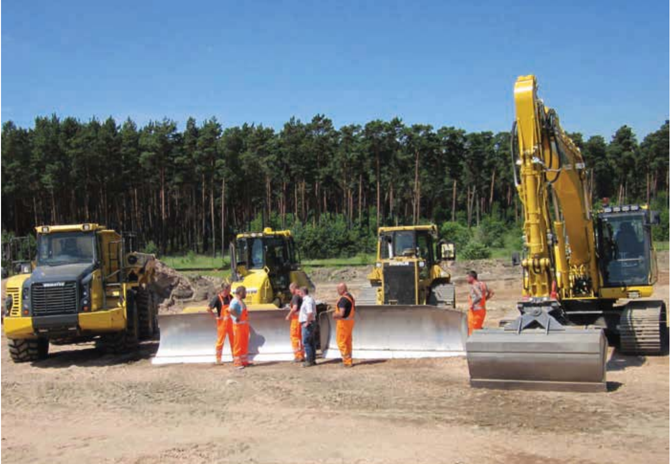
Schwere Technik wird für die Rekultivierung der Deponie „Fresdorfer Heide“ eingesetzt.
