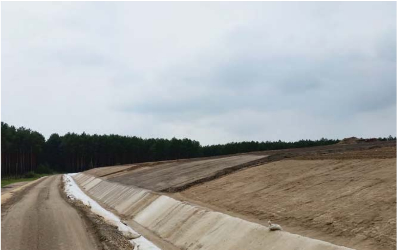
Fresdorfer Heide: Deponieumfahrung im Bau, Deponierandgraben, brauner Rekultivierungsunterboden und dunkelbraun/schwarzer Rekultivierungsoberboden (v.l.n.r.).
