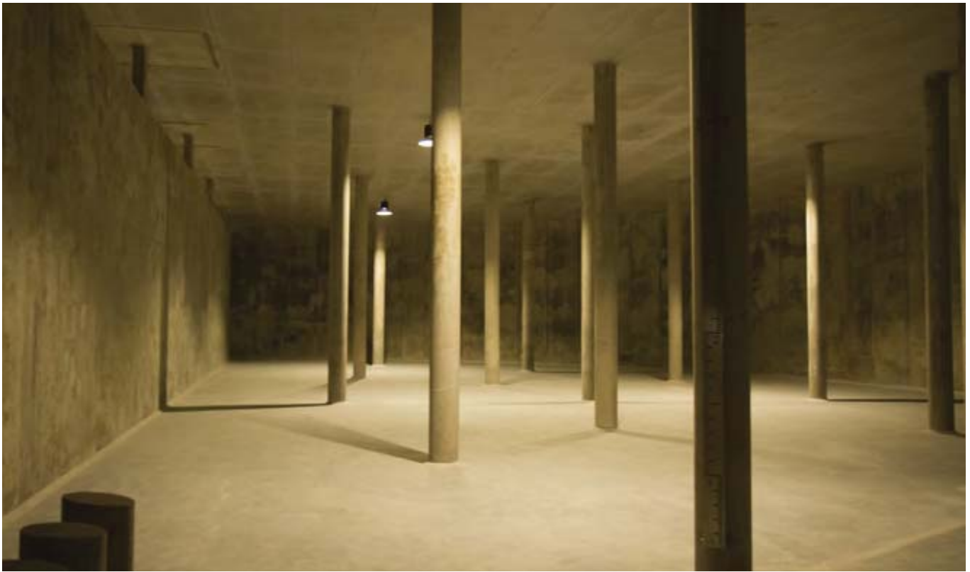
Trinkwasserspeicher Kirchberg während der Bauphase – die sieben Meter hohe Kammer hat einen Durchmesser von 40 Metern und ist inzwischen bis zur Decke voller Wasser.
