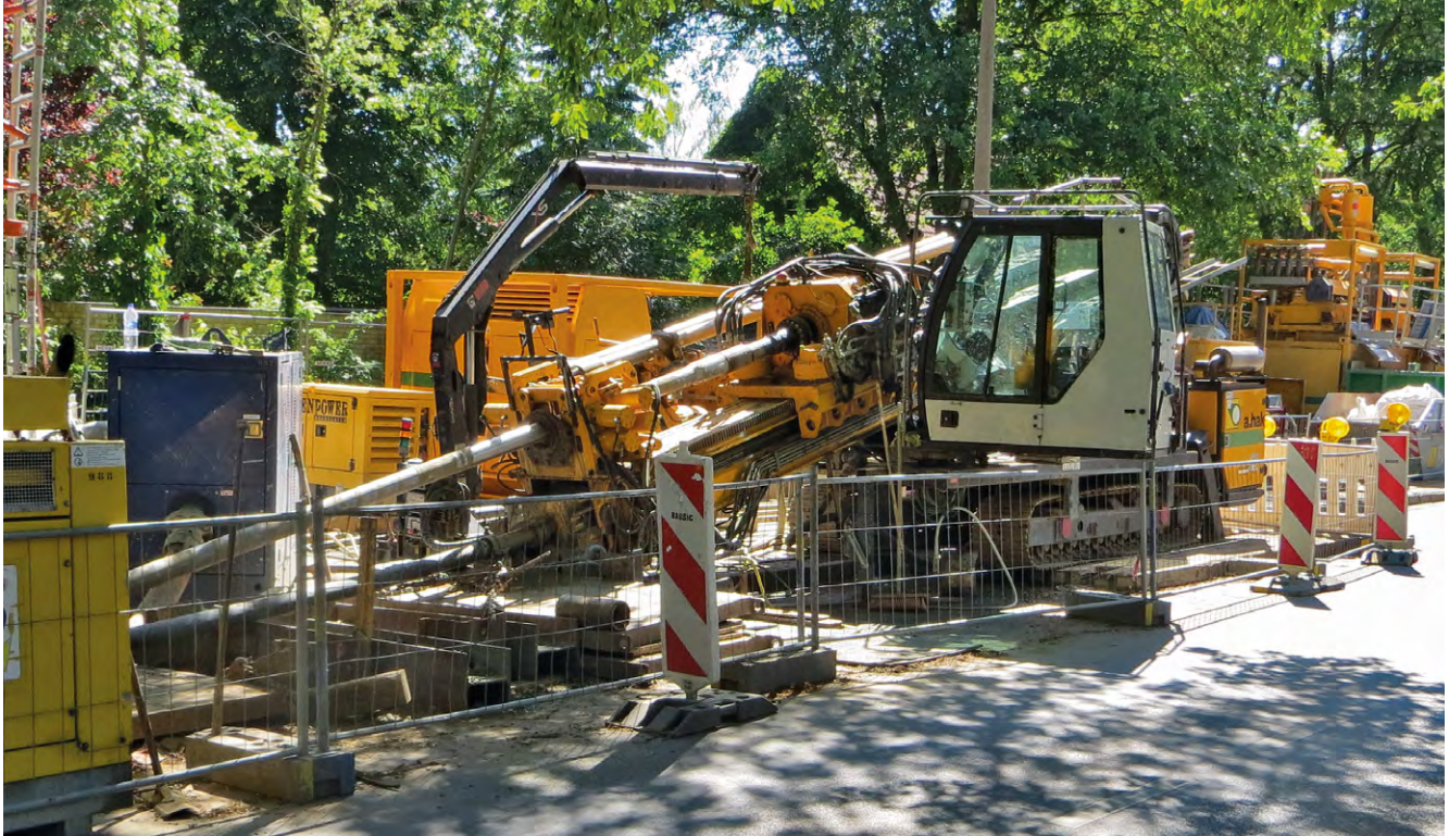
Unterirdische Verlegung von Kabeln für den 110-kV-Ringschluss
