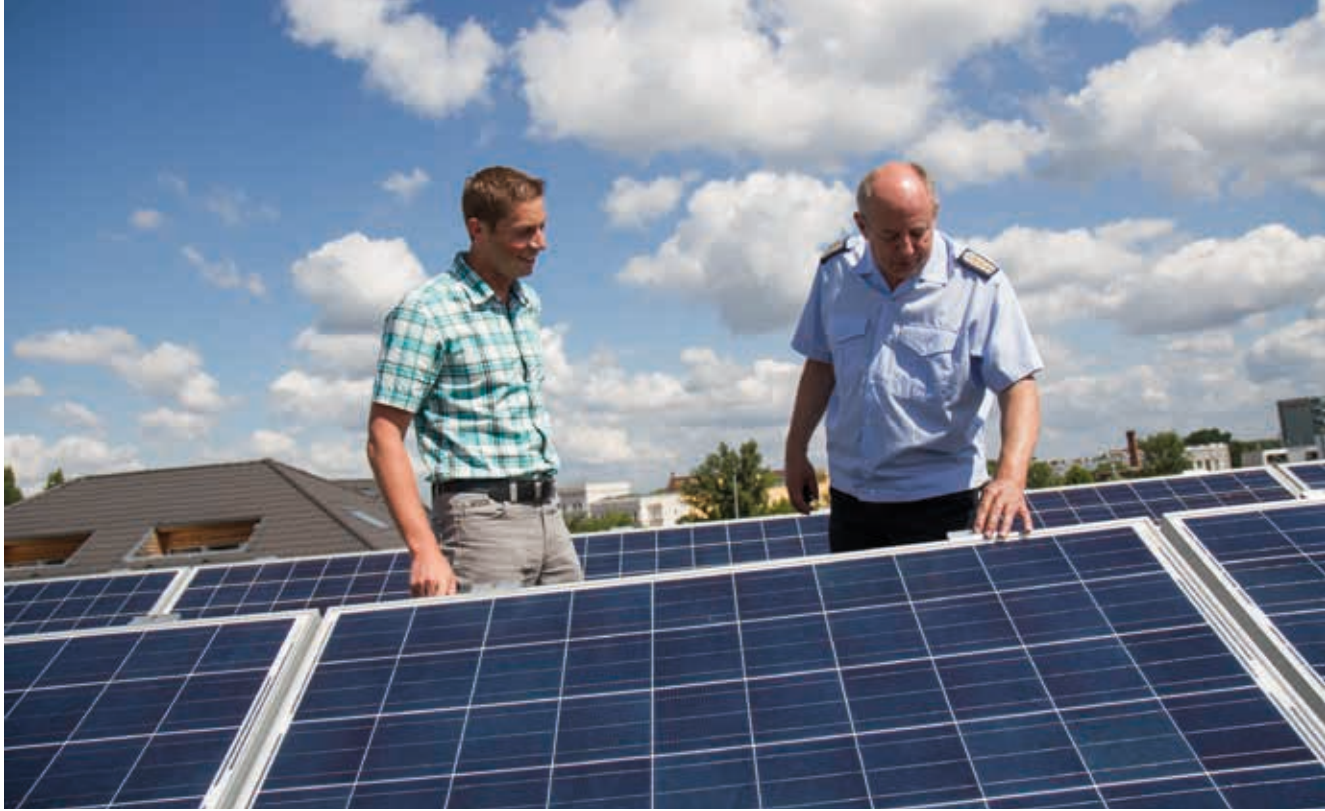
EWP-Photovoltaikanlage auf dem Dach der Potsdamer Hauptfeuerwache
