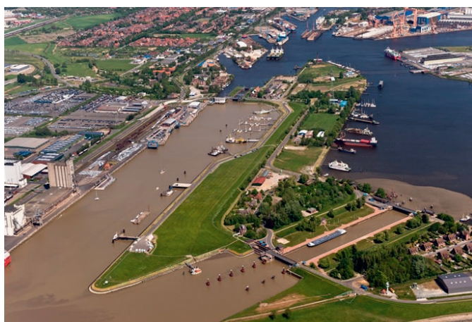
Abbildung 5: Emder Hafen; gut zu sehen ist die starke Trübung im Außen- im Vergleich zum Innenhafen (oben rechts). Foto: NLWKN
