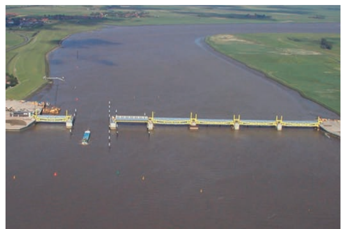
Abbildung 6: Emssperrwerk bei Gandersum (dient dem Schutz vor Sturmfluten und der Schiffsüberführung). Zukünftig sollen hier unterschiedliche Einbauten oder Steuerungsmaßnahmen zur Schwebstoffreduktion untersucht und ggf. umgesetzt werden. Foto: NLWKN
