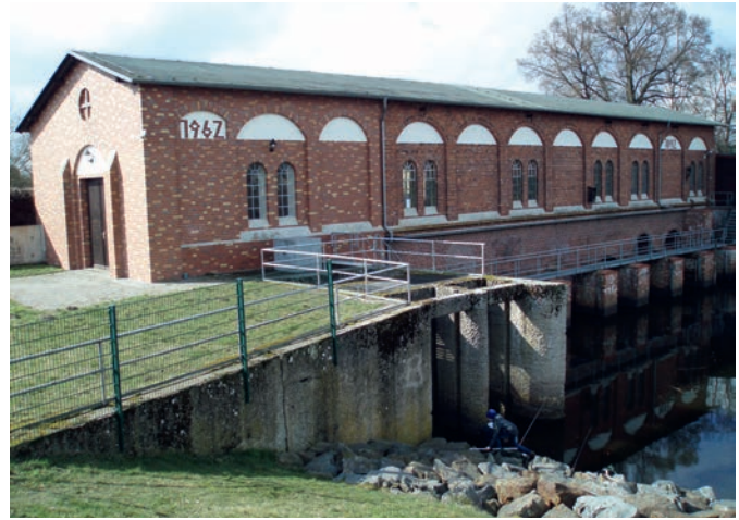
Abbildung 4: Schöpfwerk Schwedt I, eines der beiden Schöpfwerke des Nasspolders A/B. Foto: Michael Tautenhahn
