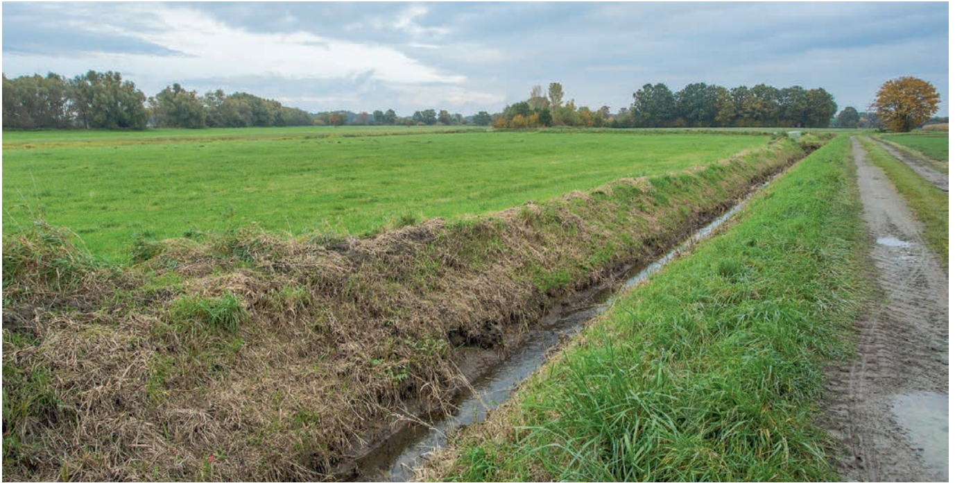
Abbildung 4: Typischer Entwässerungsgraben am Rand der Aue, der das aus einem seitlichen, ca. 2 km 2 großen Einzugsgebiet zufließende Wasser von der Aue fernhält.
