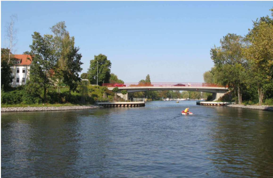
Blick auf die neue Homeyenbrücke in Brandenburg an der Havel
