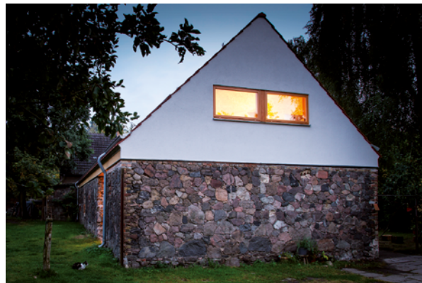
Holz im Haus – Wohnungseinbau im denkmalgeschützten Bestandsgebäude Gemeinde Schöneiche bei Berlin
