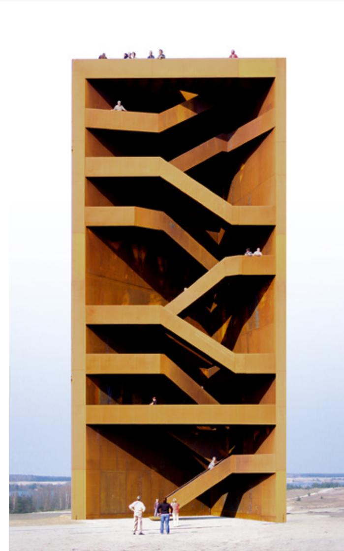
Konstruiert ist der Turm wie ein Schiff. Er besteht aus 6 mm dicken Blechen, die wie im Schiffsbau durch innen liegende Rippen ausgesteift und verbunden sind. Alle Stahlbleche sind nicht nur formbildende, sondern gleichzeitig auch statisch wirksame Konstruktionselemente. Der Turm besteht aus wetterfestem Cortenstahl, der mit der Zeit eine Patina aus Rost ansetzt. Daher wird der Turm wie die umgebende Seenlandschaft im Lauf der Jahre seine Erscheinung verändern.
