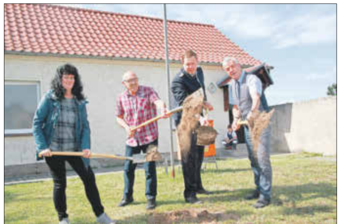
Der erste Spatenstich für das neue Feuerwehrgebäude in Kröbeln ist erfolgt.
