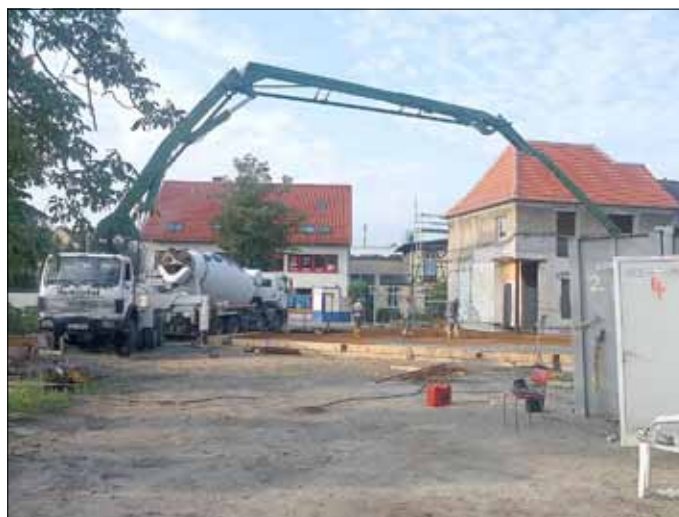
Die Bodenplatte wurde am 26. August gegossen. Foto: Doris Aust.
