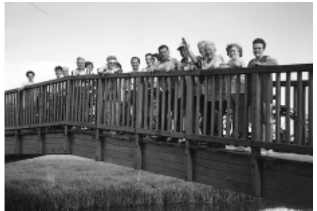
neue Brücke über die kleine Elster Wahrenbrück
