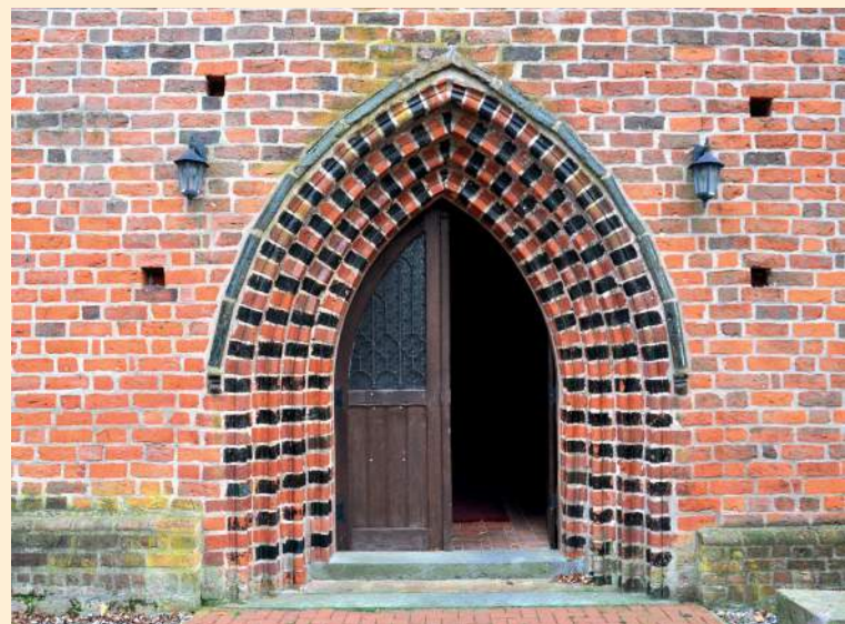
Westportal mit profilierten Gewänden
