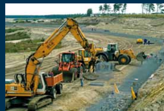
Naturnahe Befestigung einer Böschung
