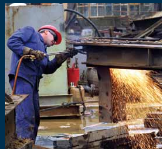
Die großen Teile müssen zerlegt werden
