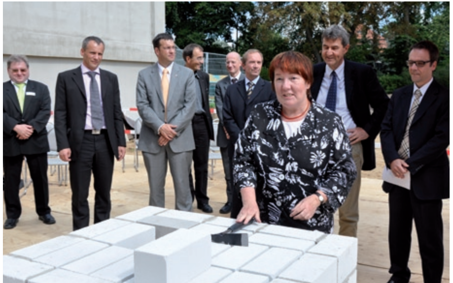
Grundsteinlegung für den zweiten Bauabschnitt am 18. August 2010
