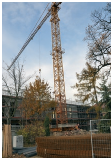
Anfang November 2010: Baufortschritt am zweiten Bauabschnitt
