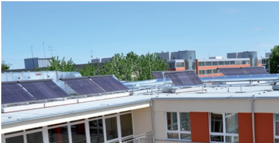
Sonnenkollektoren auf dem Dach des Albert-Schweitzer-Hauses
