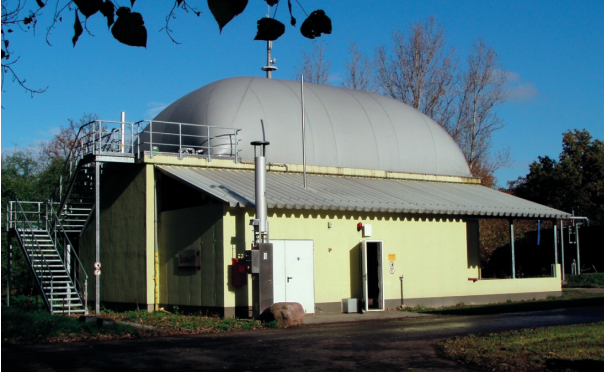
Abb. 12.8: Biogasanlage Groß Kreuz, Baujahr 2003
