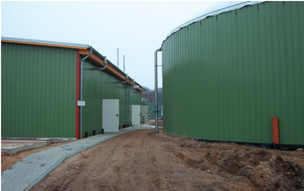
Abb. 12.3: Biogasanlage Pirow, links das Gebäude mit den Trockenfermentern und rechts der Nassfermenter
