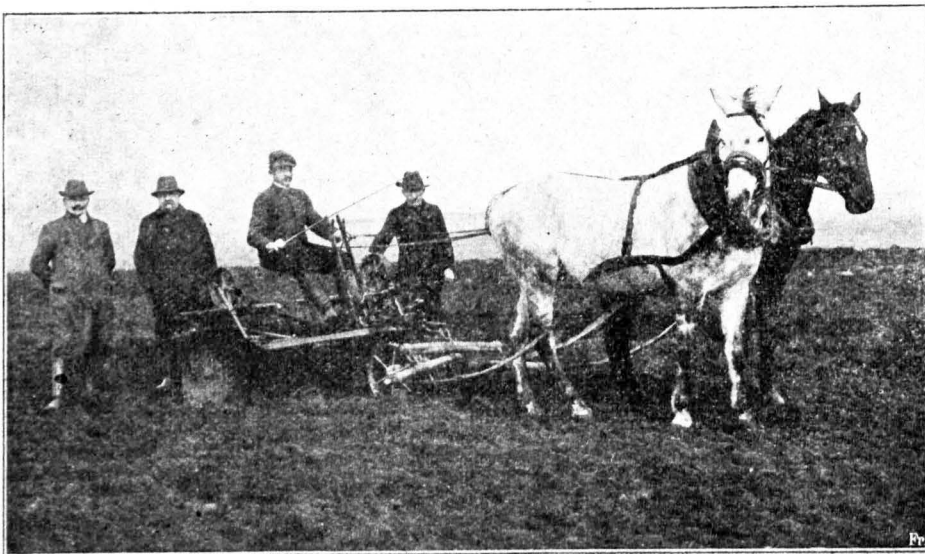
Abbildung 3. Bearbeitung der umpflügten Fläche mit der Scheibenegge.
