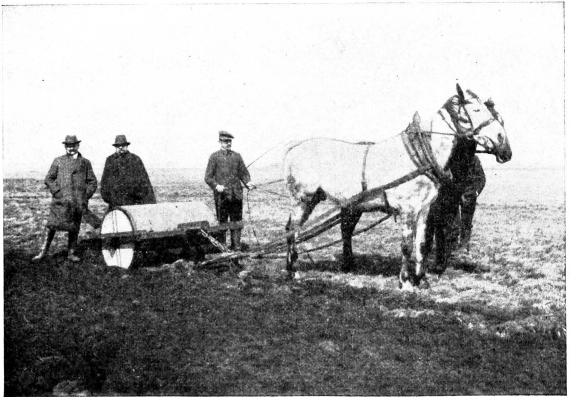
Abbildung 4. 35 Ztr. schwere Betonwiefenwalze bei der Arbeit.
