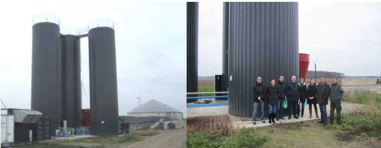
Abbildung 2 A und 2 B: 4Biogas-NOVA-Anlage des Betreibers Herrn Butschen in Viersen. Rechts Mitglieder/innen des Verbundprojektes, um zum gleichen Zeitpunkt aus dem gleichen Gefäß eine Probe vom Biogasreaktor zu nehmen.
