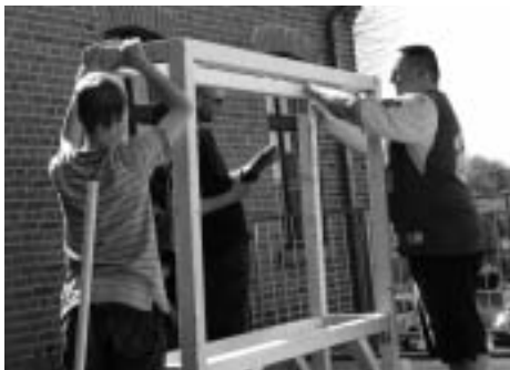
Bau des Korpus
