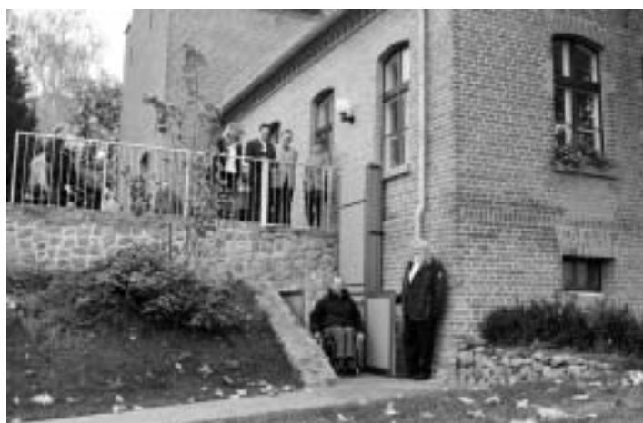
Der neue Aufzug
