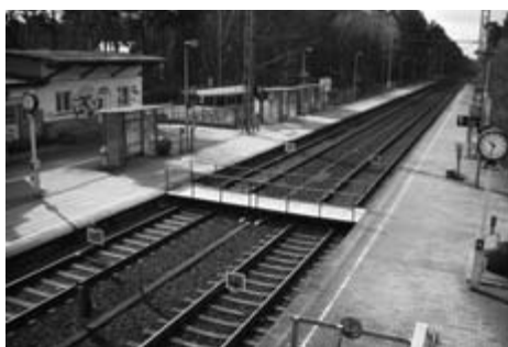
Behelfsbrücke während des Gleisbett-Baus
