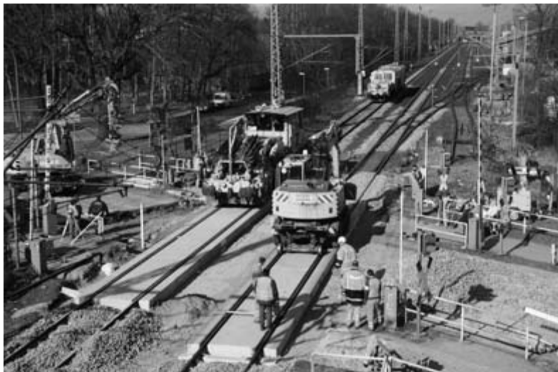
Nach der Erneuerung des Gleisbettes werden die Anschlussstellen wieder hergestellt
