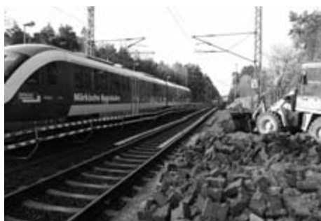
5. April: Bahnsteig 1 wird erneuert, die Züge fahren von Bahnsteig 2
