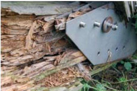
Holz rotet vor sich hin, Muttern und Schrauben fehlen schon – das ist die Verankerung unter der Brücke, von Stabilität keine Spur.
