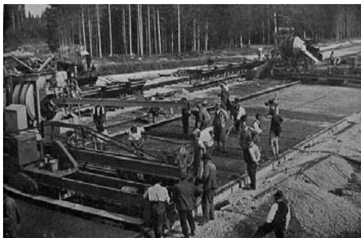
Die Betonbahnen werden gegossen, ein damals total modernes Verfahren.
