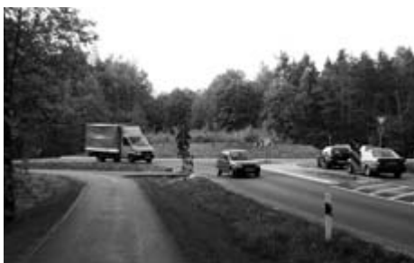
Der Philippthaler Kreisel ist wieder frei gegeben. Aus Richtung Nudow und Ludwigfelde kommend, geht der Radweg nicht nach rechts weiter. Der Radler wird mit Gegenverkehr links um den Kreisel und auf die andere Straßenseite geführt. Nudows Ortsvorsteher Harald Schmidt-Urbich sieht das als Verkehrsgefährdung an.
