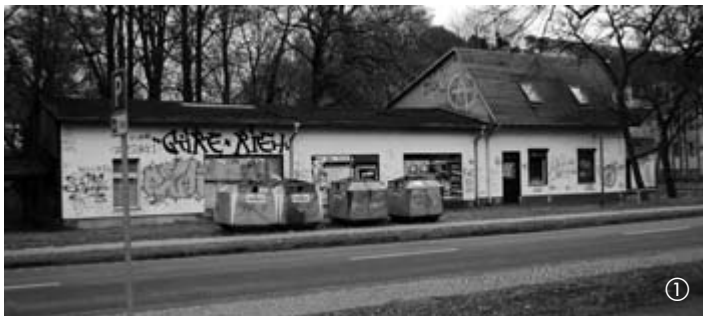
Vor dem Abriss
