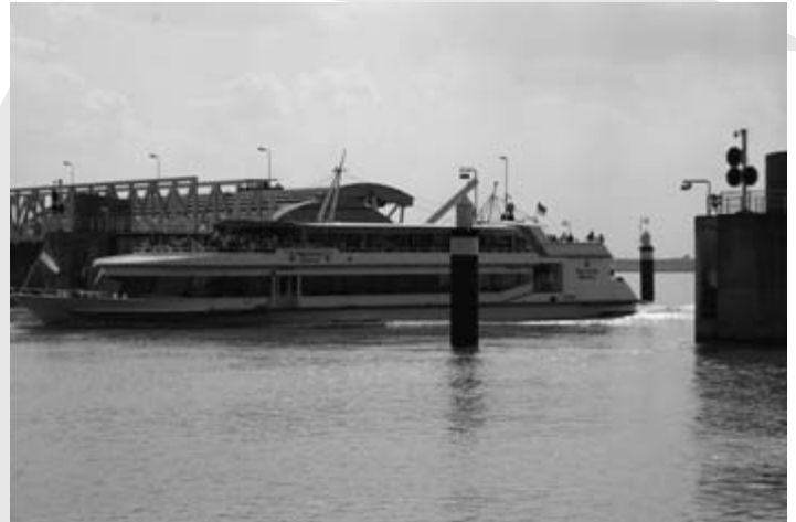
Das Passagierschiff „Warsteiner Admiral“ durchfährt die 60 Meter breite Hauptschiff-fahrtsöffnung des Emssperrwerkes
