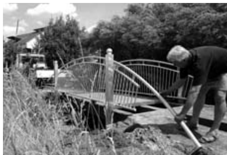
Eine der neuen Brücken im Bau
