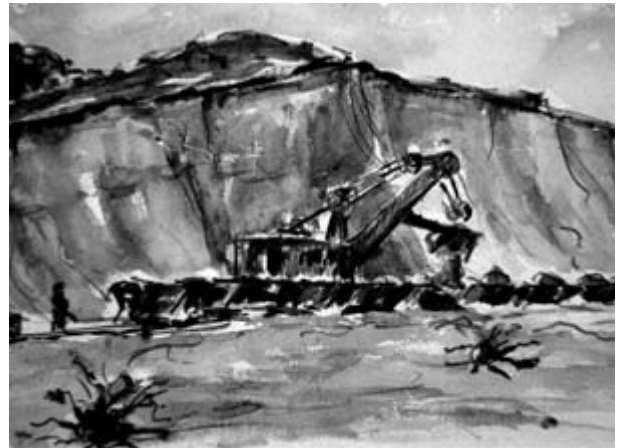
Durchbruch der eiszeitlichen Formation der Leisberge für den Autobahnbau
