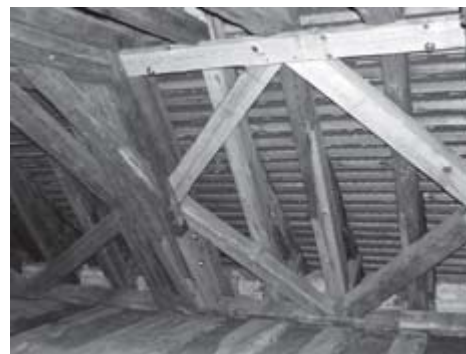
Der Dachstuhl ist bereits vom Schwamm befreit. Aber es gibt noch viel zu tun Fotos: Haenel (3), Kaupke (1)
