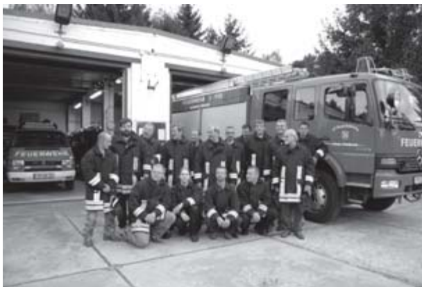
Hauptwehr Bergholz-Rehbrücke (Soll: 18, Ist: 35 Kräfte): Das 45 Jahre alte Gebäude muss saniert, umgebaut oder ersetzt werden. Die Bedingungen rund um die freiwillige Brand- und Katastrophenhilfeinsätze sind unzureichend. Für 25 Einsatzkräfte stehen keine Duschen und nur eine Toilette zur Verfügung. Für dringend notwendige Nachwuchsförderung ist kein Platz.
