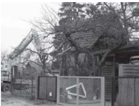
Die alte Fachwerkscheune in der Ravensbergstraße in Bergholz fiel dem Abrissbagger zum Opfer.
