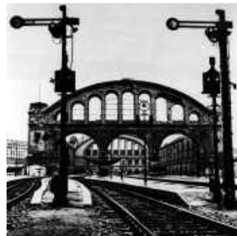
Der zerstörte Anhalter Bahnhof 1945. Aus „Neubeginn“, Nicolai 1995
