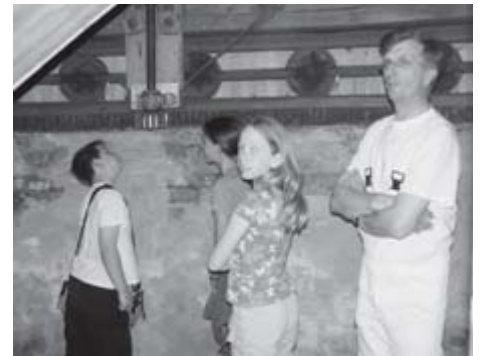
Wir stehen im „Keller“ unter der Mühle! Die ganze Mühle lagert auf vielen Rollen, wie sie im Hintergrund zu sehen sind. Darunter ist der große Rollenkranz zu sehen.
