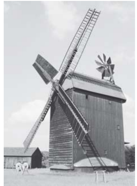
Das ist die Langerwischer Mühle. Das kleine Rad auf dem Dach ist wichtig, damit sich der ganze Bau in den Wind drehen kann. Fotos: Bio-AG
