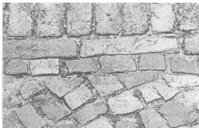
Pflasterwechsel in Ausfahrten
