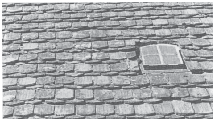
Historische Dacheindeckung, Biberschwanz – Kronendeckung, § 5 Abs. (5)
