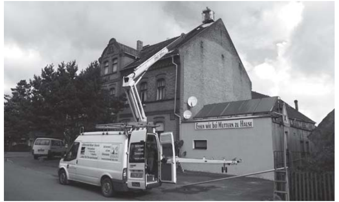
Installation der Richtfunkantenne auf dem Gasthof Meuro durch die Firma LKG aus Lauchhammer.
