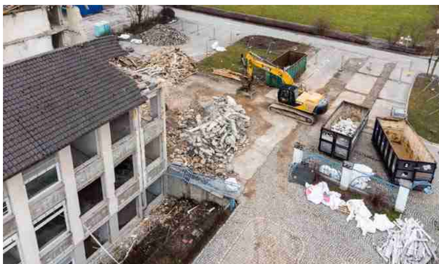
Foto: Abriss der alten Schule aus der Vogelperspektive
