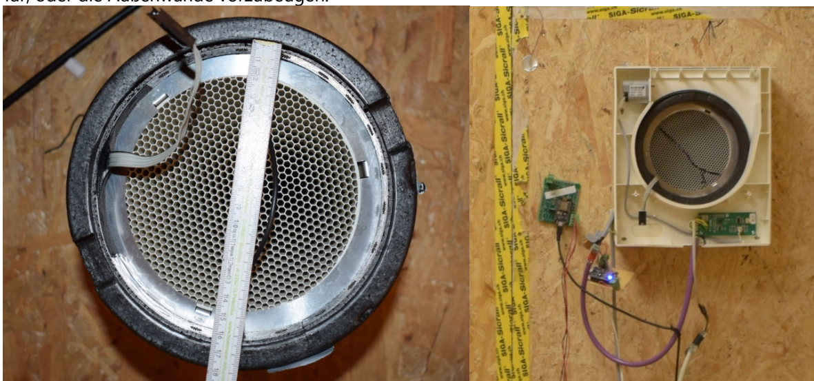
Abbildung 21 li. Pendellüfter mit wabenförmigem Wärmespeicher, ohne Abdeckung; re.: Pendellüfter mit Ansteuerungselektronik
