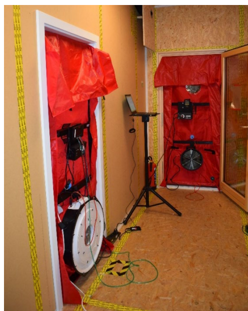
Abbildung 29 Leckage Messung in der Forschungswohnung, hier eingebaute Blowerdoor in Haustür und Badezimmer-Tür
