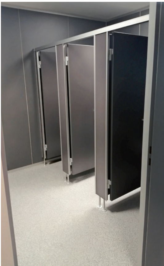
Abb. 5: Gutes Zusammenspiel der Sanitär-Trennwände und dem Vorwand-Elementsystem. Quelle: Holz'akzente GmbH & Co. KG
