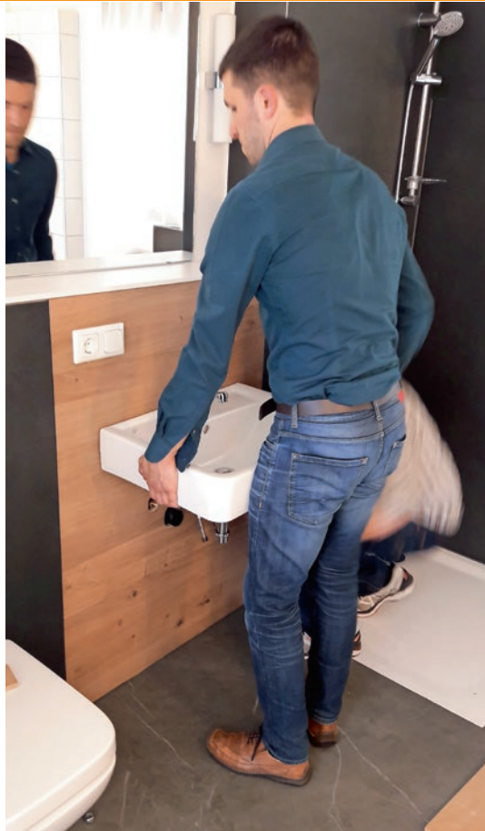
Abb. 5: Demonstration der schnellen Revisionsbarkeit Mock-up Container. Bild: TH Rosenheim
