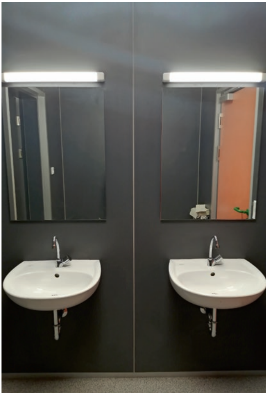
Abb. 4: Im Pilotprojekt fertiggestellte Sanitär-Vorwand mit Waschbecken Elementen. Quelle: Holz'akzente GmbH & Co. KG
