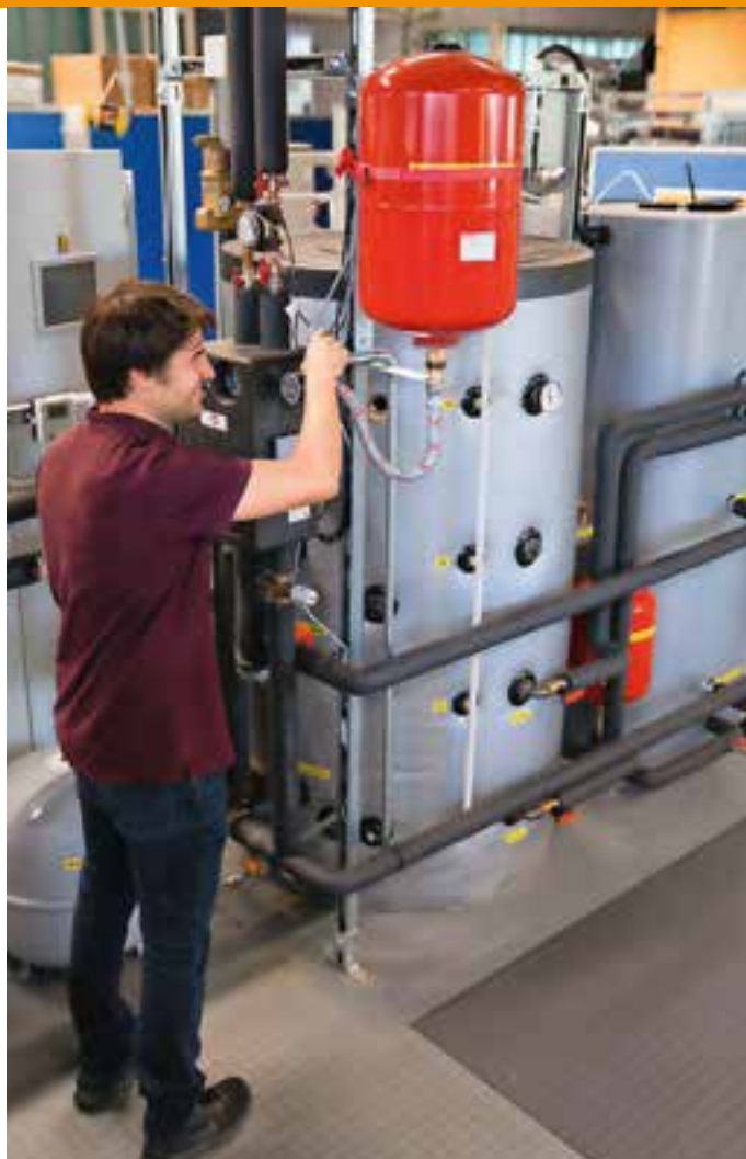
Abb. 2: Im Labor stehen Wärmepumpen für Forschungsvorhaben bereit. Bild: TH Rosenheim, Klaus Schmidt
