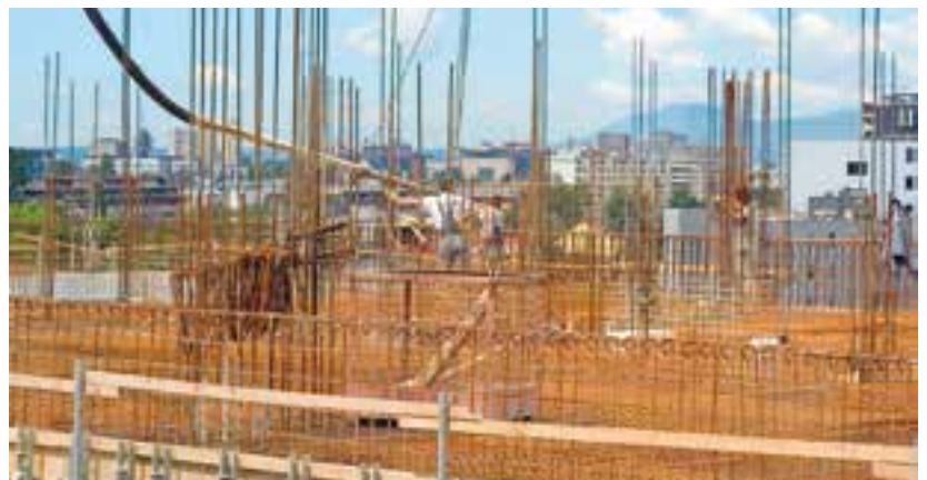
Abb. 3: Bevor der Beton zum Einsatz kommt, wird auf der Baustelle mit großem Aufwand die typische Stahlbewehrung in die Konstruktion eingebracht.
