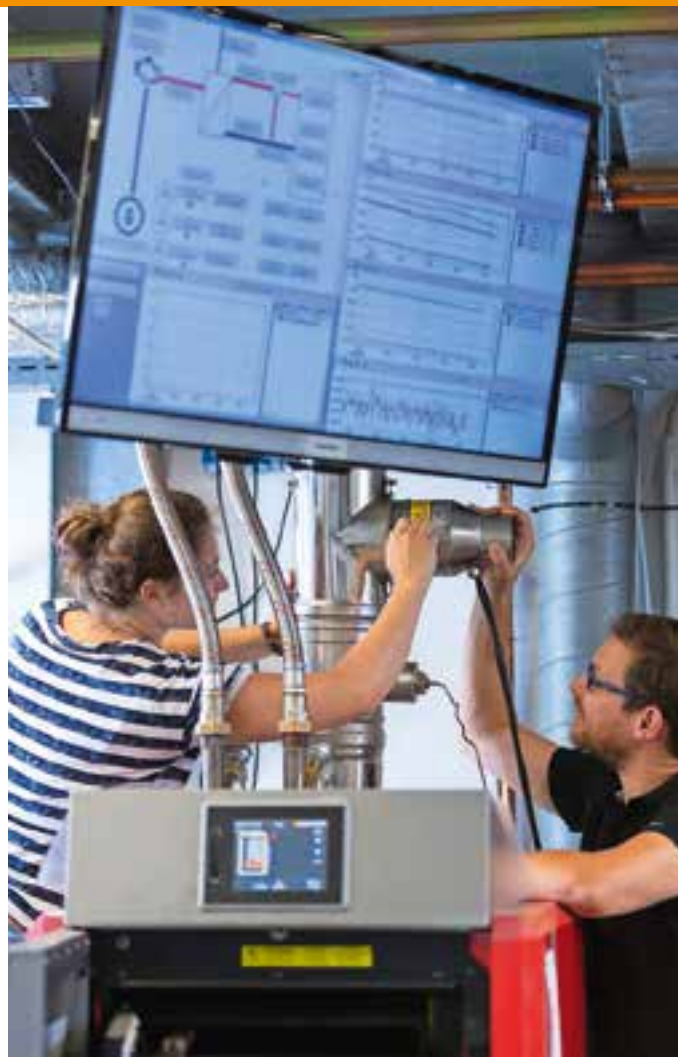
Abb. 3: Auch an Pufferspeichern werden Untersuchungen vorgenommen. Bild: Florian Hammerich
