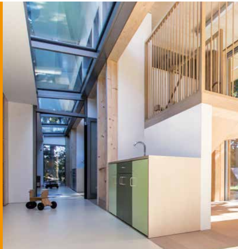
Die Glasfuge (links oben im Bild) wurde als verbindendes Element zwischen Bestands- und Neubau gesetzt.
