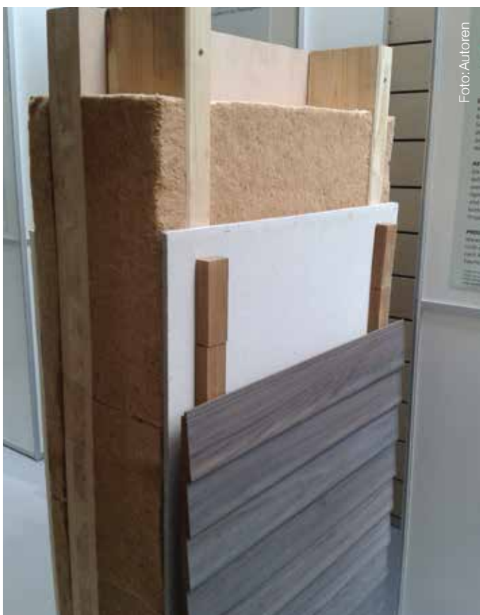
Beispielhafter Außenwandaufbau des Holzbausystems Südharz – Kombination der Einzelkomponenten: thermomodifizierte Fassadenschalung, buchenbasierter Holzfaserdämmstoff, Buchen-Kiefern-Hybrid-Brettsperrholz, Gipswerkstoffplatte
