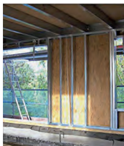
Abb. 3: Montierte Wand- und Deckenelemente in Stahlleichtbauweise
