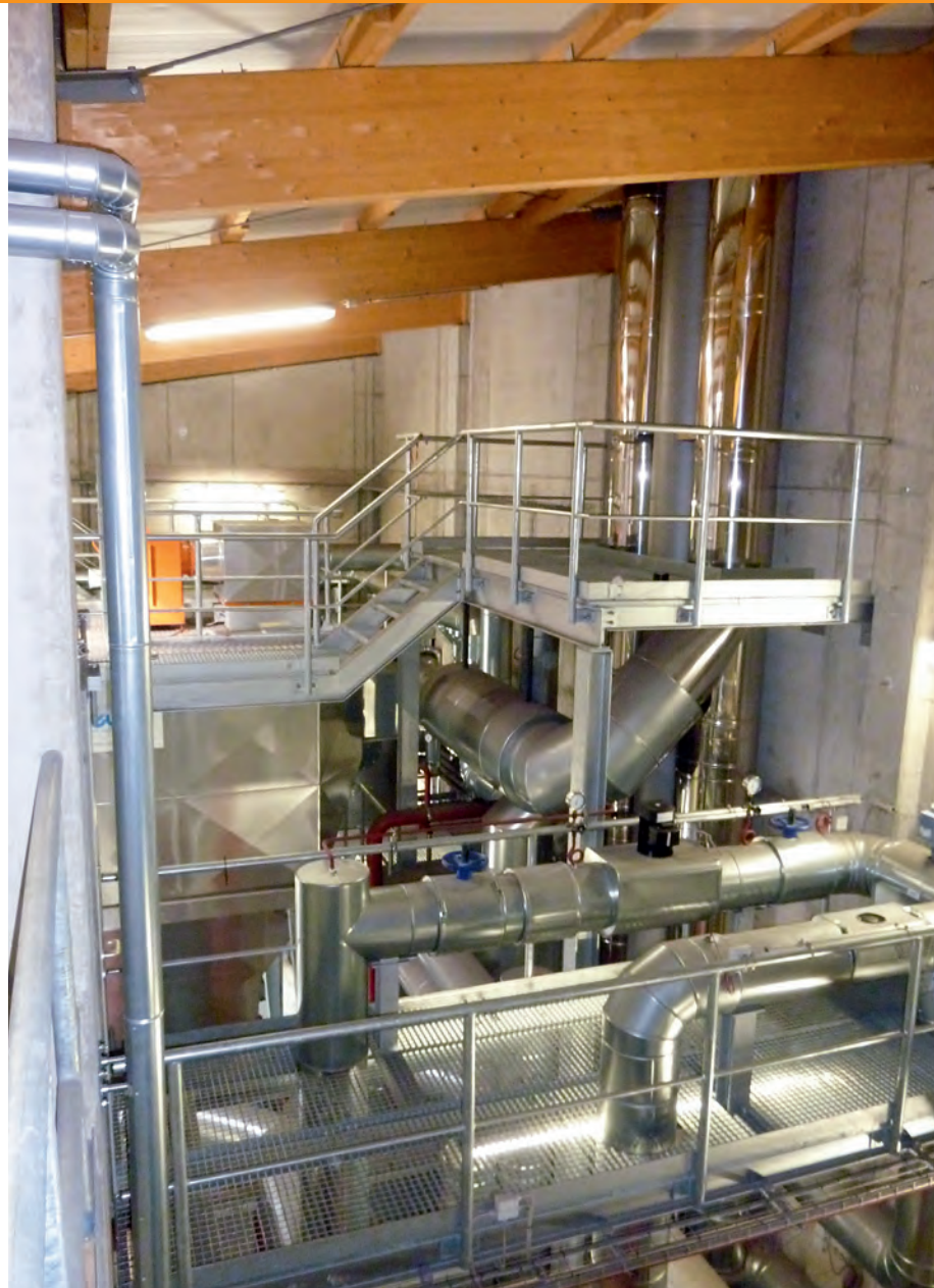
Abb. 2: Vor-Ort-Begehung im Heizwerk
