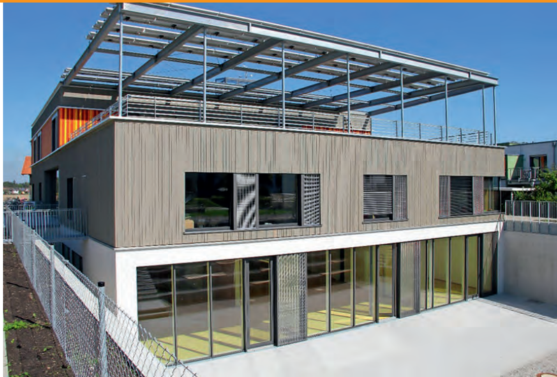
Abb. 1: Südansicht des Plus-Energie-Kinderhauses in Höhenkirchen-Siegertsbrunn Bild: Fraunhofer IBP
