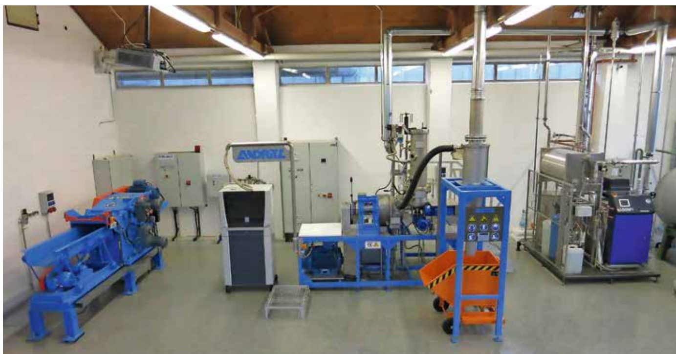
Abb. 2: Die Refineranlage mit Trommelhacker (links), Refiner (mitte) und Dampferzeuger (rechts).
