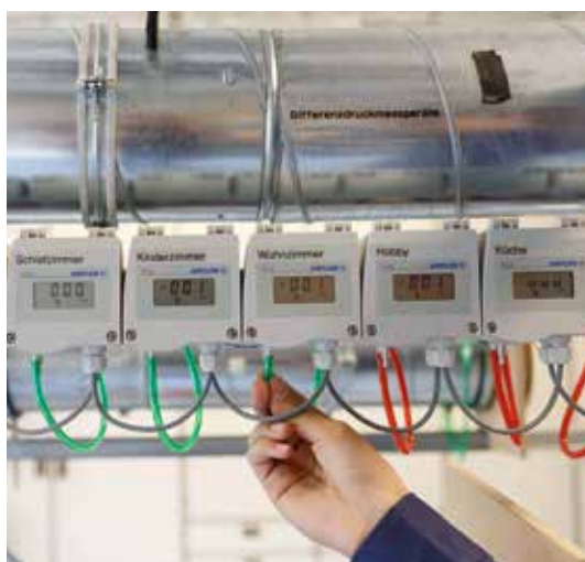
Differenzdruckmessgeräte für jedes Zimmer der Forschungswohnung Bild: Florian Hammerich
