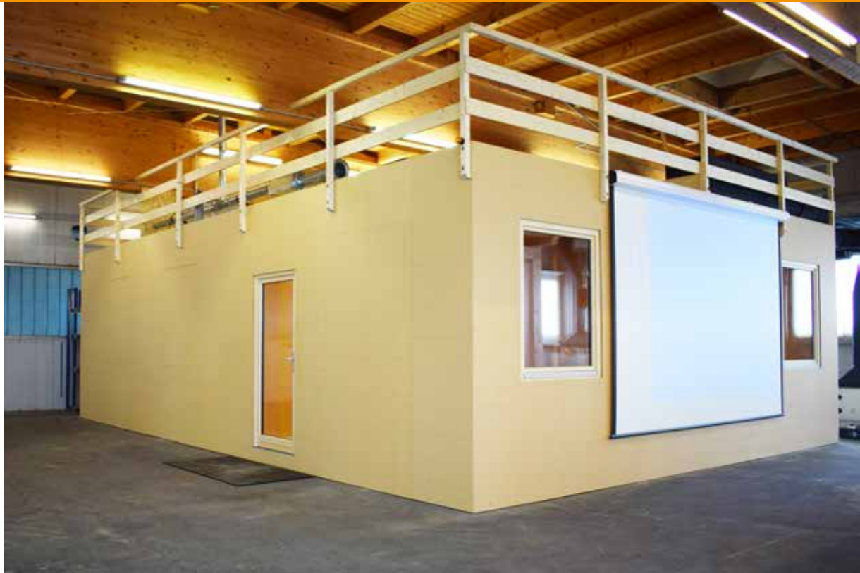
Die neu errichtete Forschungswohnung im Realmaßstab.
