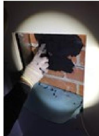
Abbildung 7.27: Applikation der Absorber-Klebeschicht auf dem Vollziegelmauerwerk. Abbildung entnommen aus [86].
