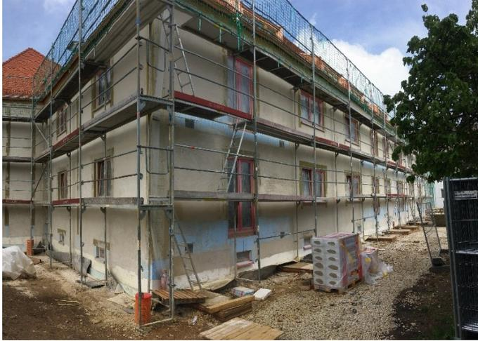
Abbildung 10.42: Fassade in der Trocknungsphase
