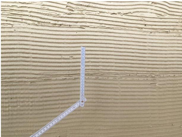
Abbildung 10.34: Haftvermittler vor dem Auftrag der Spritzbaren Dämmung
