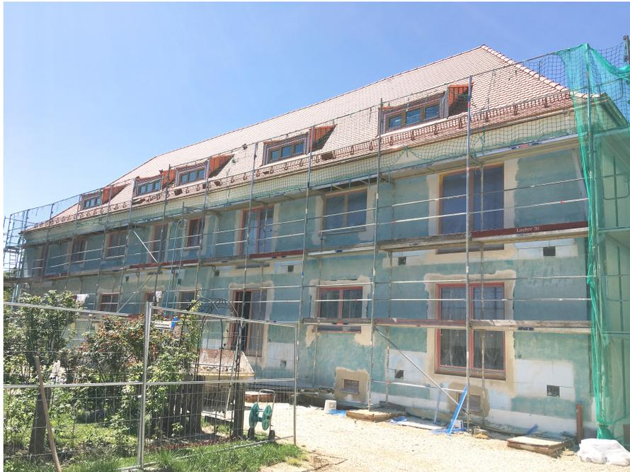
Abbildung 10.47: 07. Mai 2020: nach ausreichendem Abtrocknen grundierte (blaugefärbt) Fassade
