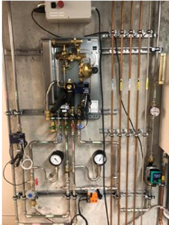
Abbildung 12.2: Aufbau einer Frischwasserstation
