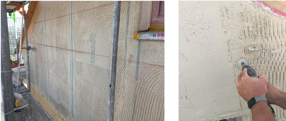
Abbildung 10.46: Statische Sicherung der Dämmplatten mittels Verdübelung
