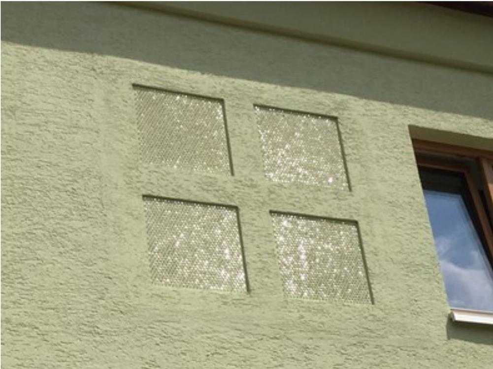
Abbildung 7.41: Solarselektives Wärmedämmsystem am Demonstrationsgebäude
