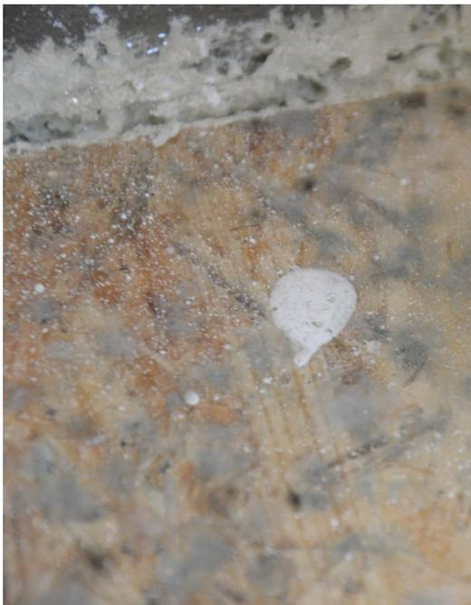
Abbildung 10.12: Holzfußboden mit Schimmelpilzbewuchs
