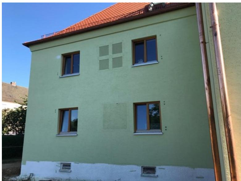
Abbildung 9.2: Testfassade mit südlicher Ausrichtung und den Testflächen solaraktiver Putz im OG, der Testfläche Strahlungsmanagement im EG und der dazwischen liegenden Referenzfläche
