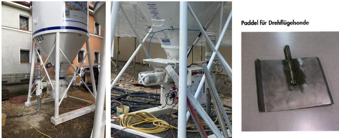
Abbildung 10.36: Silo mit Luftauflockerung und Teil der neuen Messsonde
