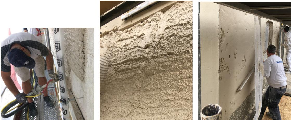
Abbildung 10.40: Links: Aufspritzen eco m 720. Mitte: Spritzbild bei etwa. 7 bis 8 cm Dicke vor dem letzten Spritzgang. Rechts: Einebnen der Putzfläche nach Erreichen der 10 cm Dicke
