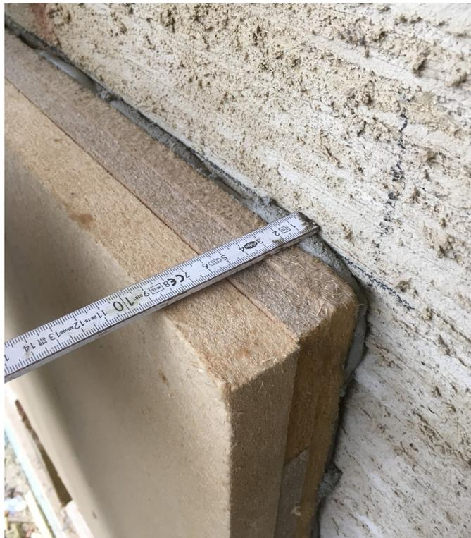
Abbildung 9.6: Strahlungsmanagement-Prototyp mit einem vollständigen Aufbau von 7 cm und einer Klebewulst von 2 cm
