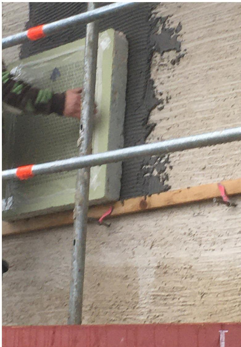
Abbildung 9.7: Anbringung der Prototypen-Felder zum solaraktiven Putz
