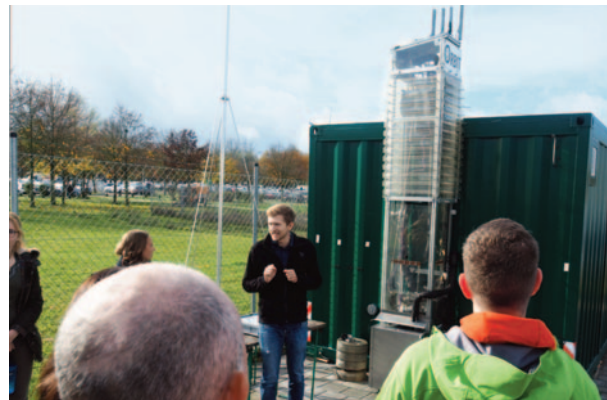
FENES-Mitarbeiter Michael Heberl erläutert die grundlegende Funktionsweise der Methanisierung und erklärt, wie diese an der Methanisierungsanlage umgesetzt wurde.
