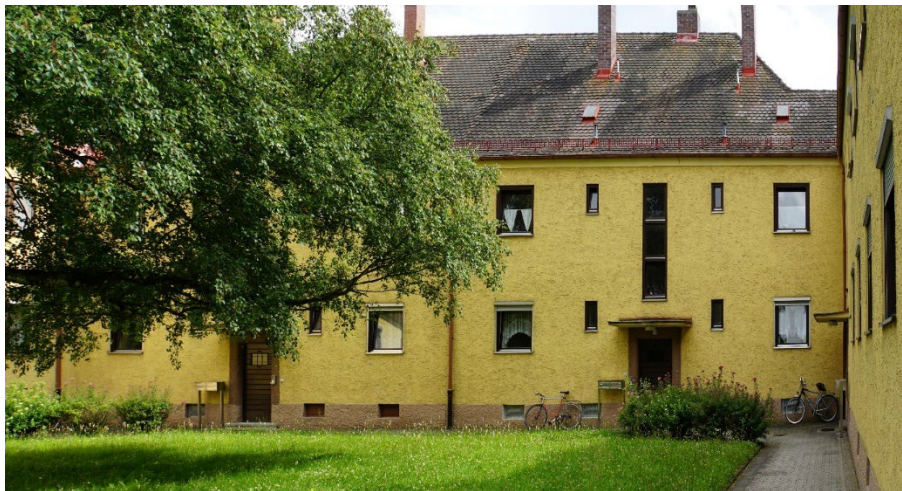
Abbildung 4: MAGGIE-Testgebäude, Margaretenau Regensburg (Quelle: Annika Zeitler, OTH Regensburg)
