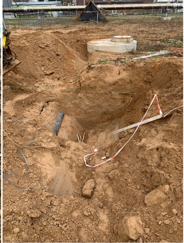
Abbildung 31: MSQ2 Nord – Auffüllung/Wiederverfüllung mit Aushubmaterial Sand
