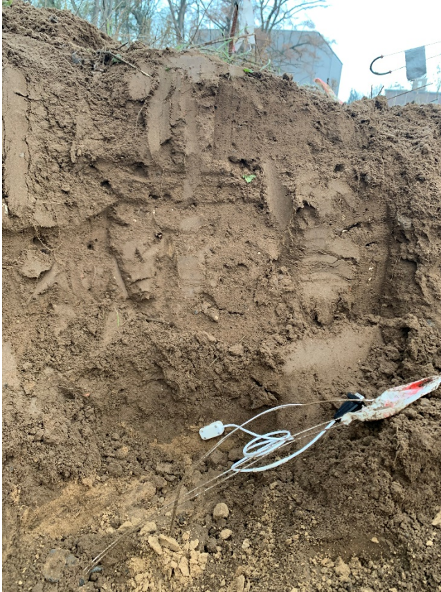
Abbildung 30: MSQ1 Süd – Auffüllung/ Wiederverfüllung mit durchwurzeltem Oberboden
