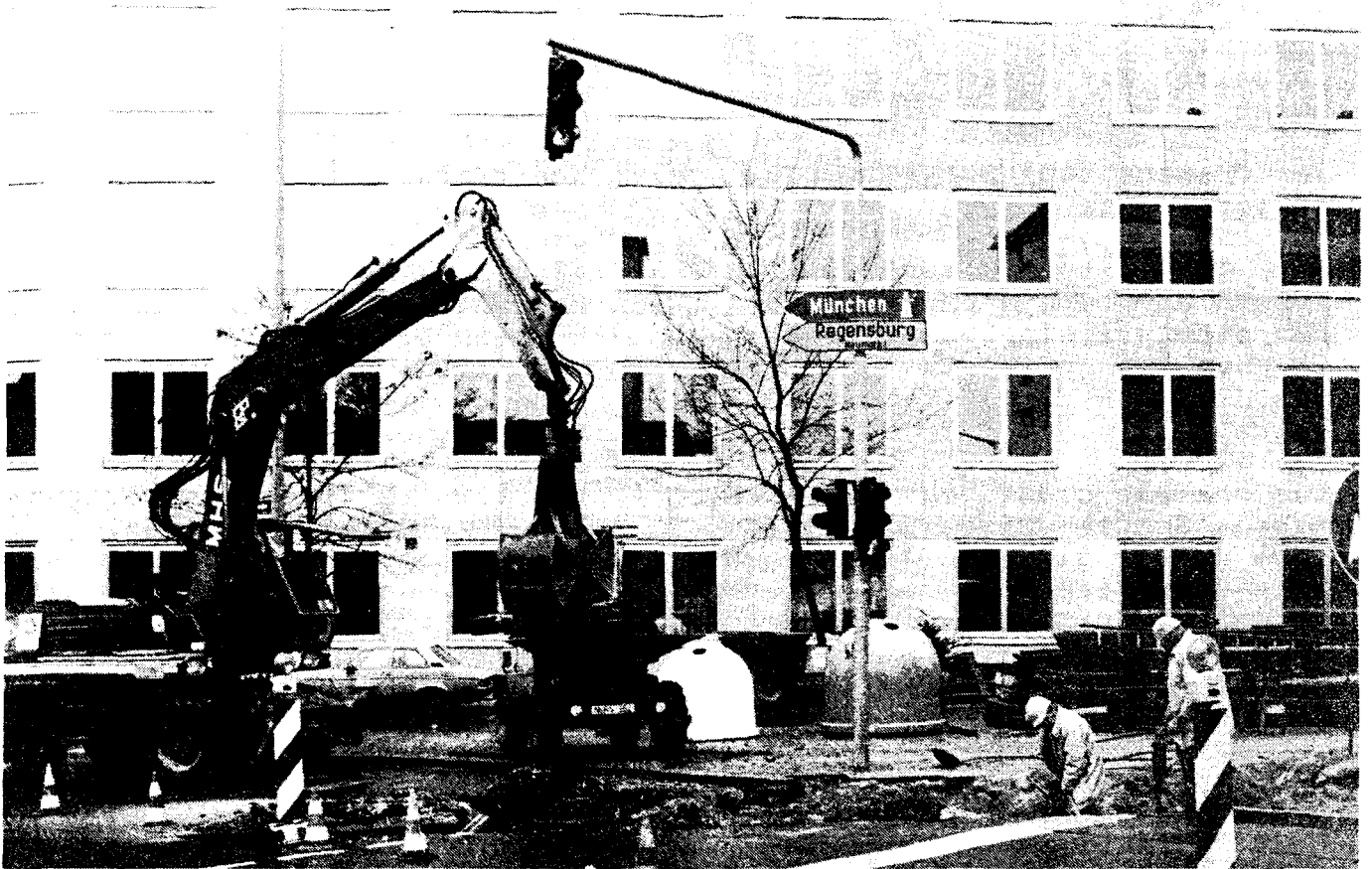
Anschluß der FHN an das Fernwärmenetz der Stadt Nürnberg: Erdarbeiten der EWAG vor dem A-Gebäude
