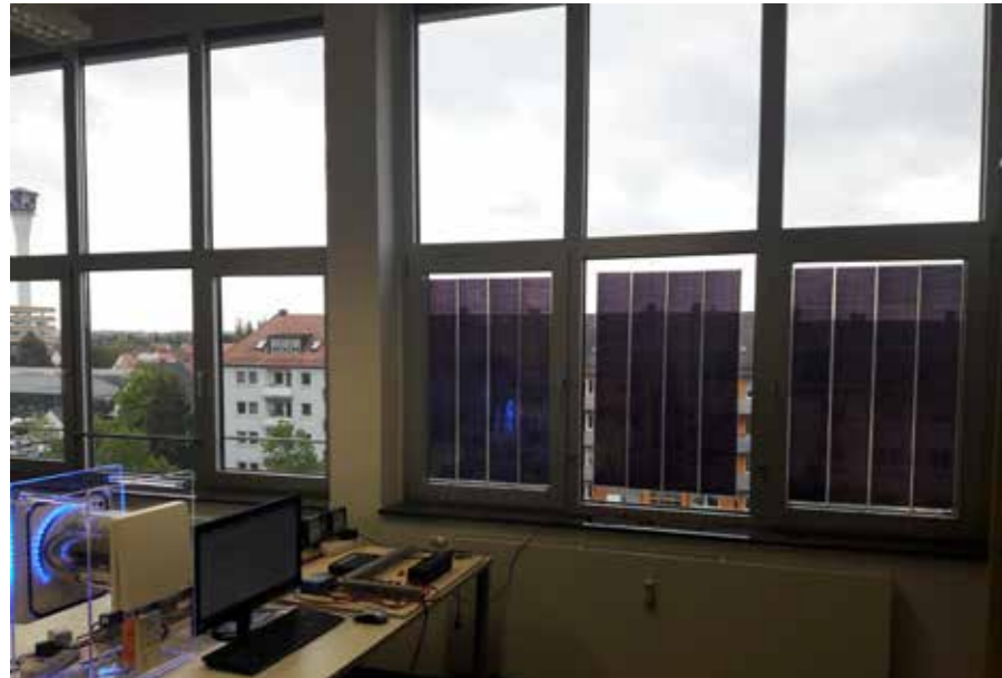
Versuchsstand zur aktiven Fassade am Energie Campus Nürnberg
