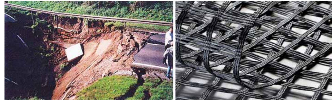
Erdfall unter einer Straße (links) und Geogitter zur Bodenbewehrung (rechts).
