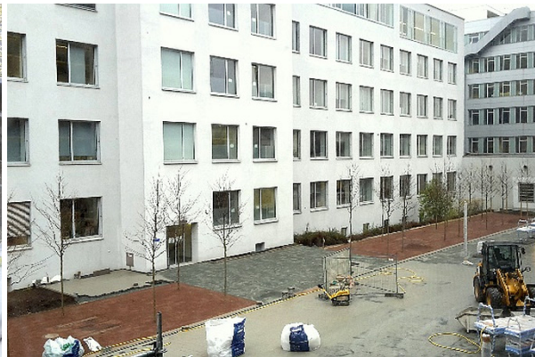
Umgebung des KB-Gebäudes im Bauzustand
