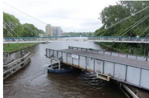
Fuß- und Radverkehrsbrücke an einer Drehbrücke Foto: Müller/Morcelli
