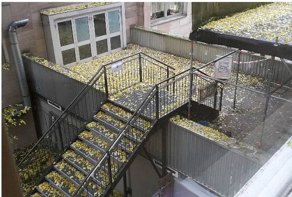
Seitlich verlegtes Eingangstreppenhaus Fotos: Thomas Freimann
