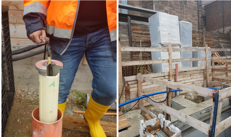
Messung Inklinometerrohre Fotos: Bernd Plaßmann
