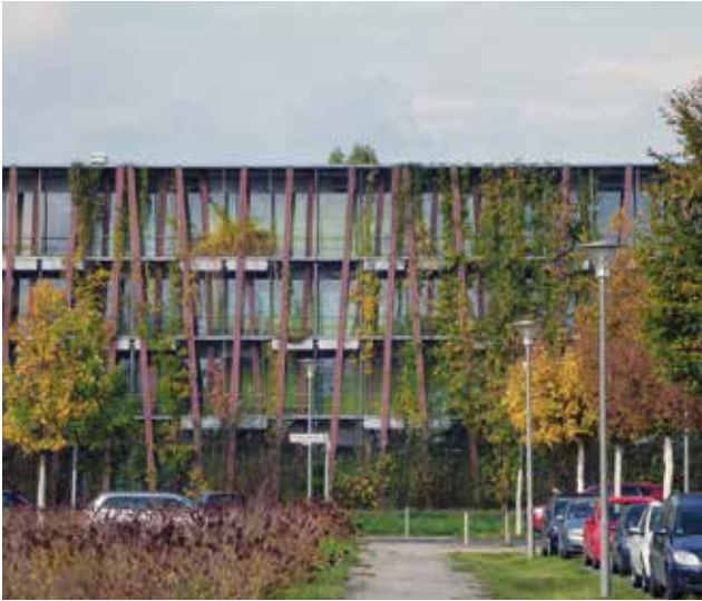
Abb. 1 Berlin, Institut für Physik der Humboldt Universität Berlin (2000-2003); Augustin und Frank Architekten, Berlin
