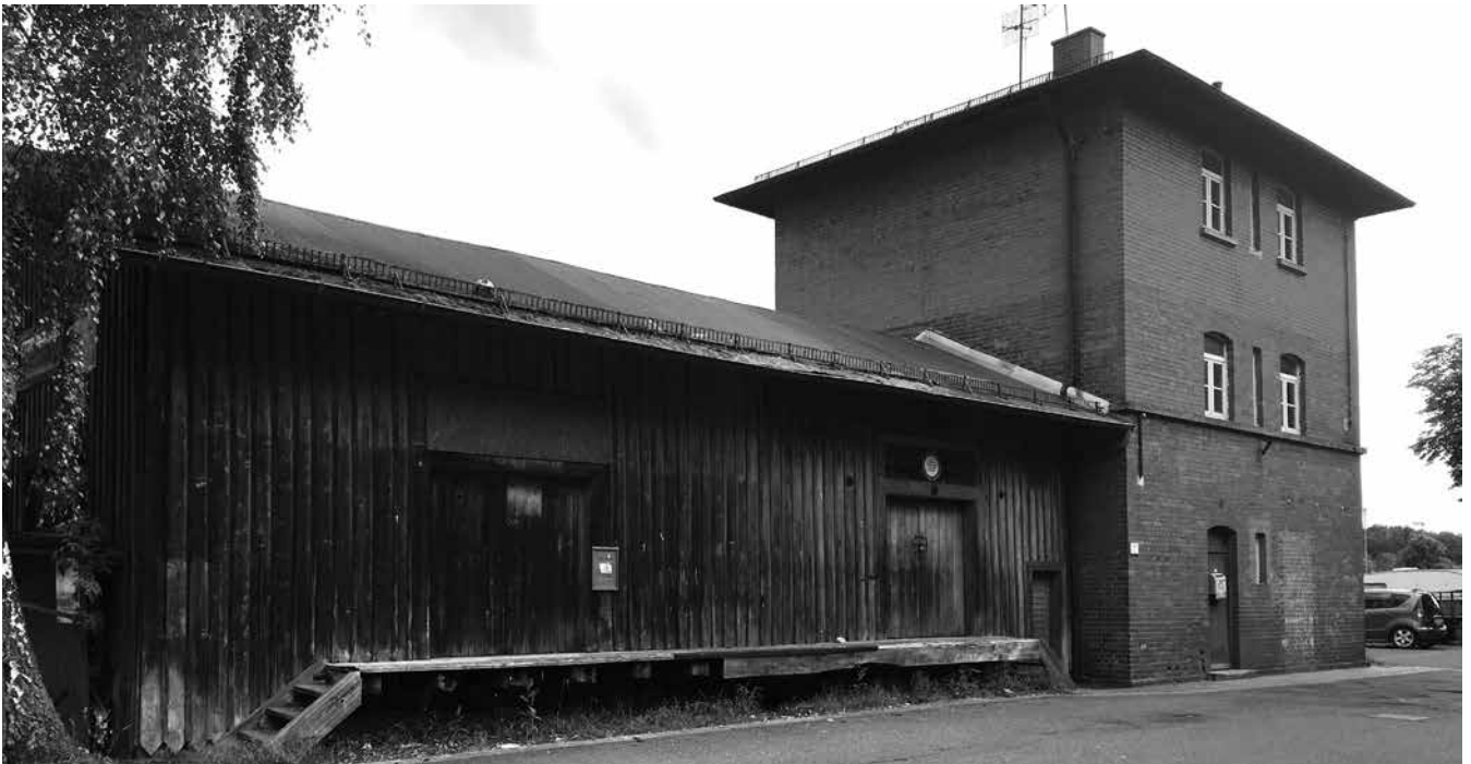
Bahnwächterhaus im Wilhermsdorf
